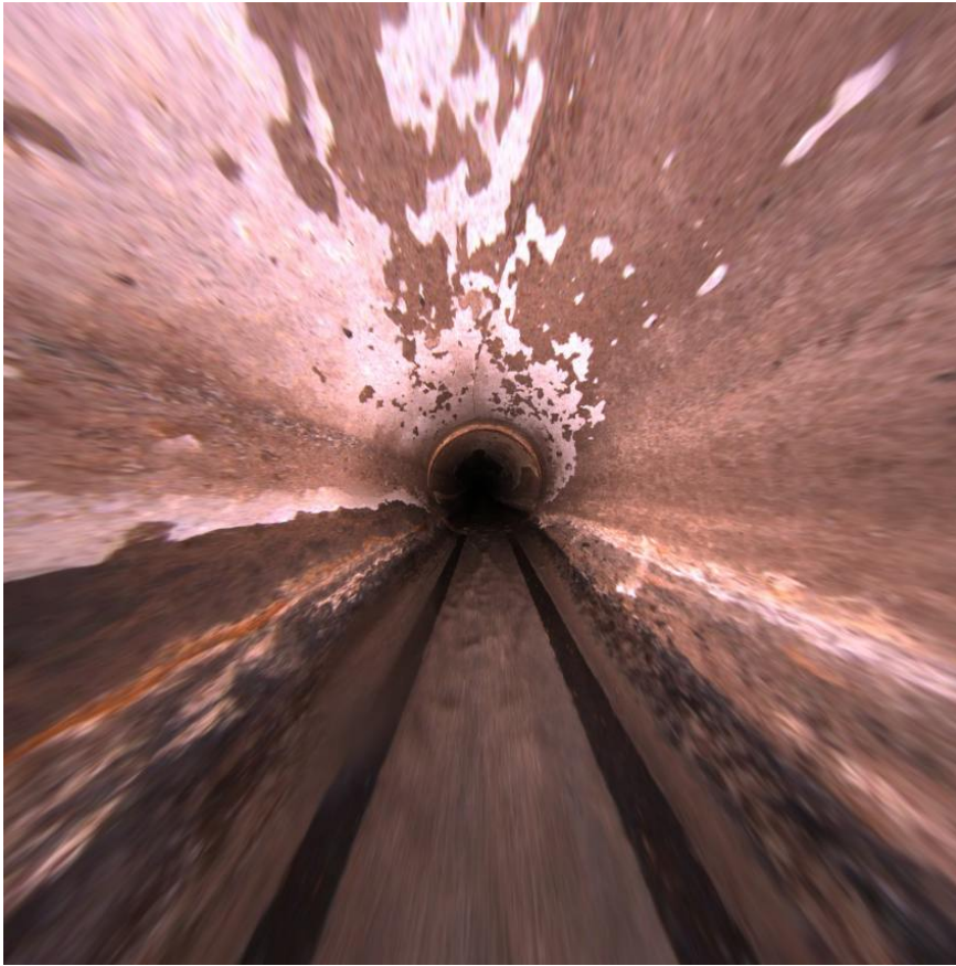
Abbildung 7: Von einer Fischaugenkamera aufgenommenes Bild, welches in die Sicht einer Lochkamera umgerechnet wurde.
